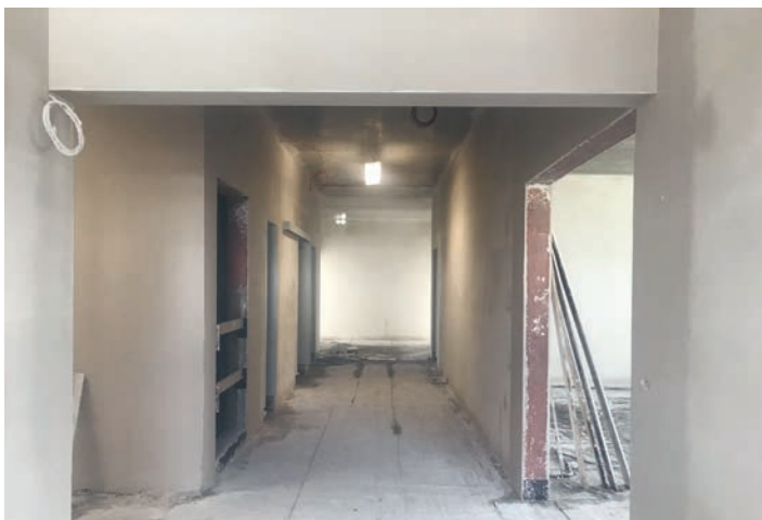
So sieht es zur Zeit auf der Baustelle aus
