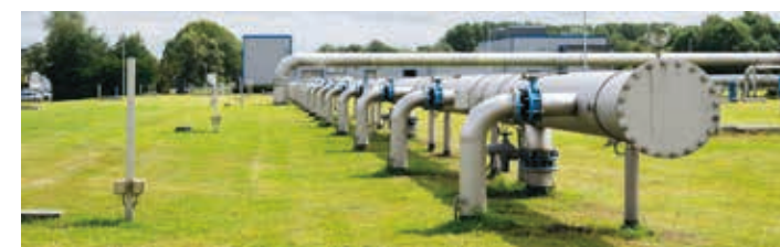
Ein Belebungsbecken von außen, mit dicken Luftleitungen ...und leer mit neuen Plattenbelüftern (unten).
