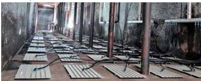
Ein Belebungsbecken von außen, mit dicken Luftleitungen ...und leer mit neuen Plattenbelüftern (unten).
