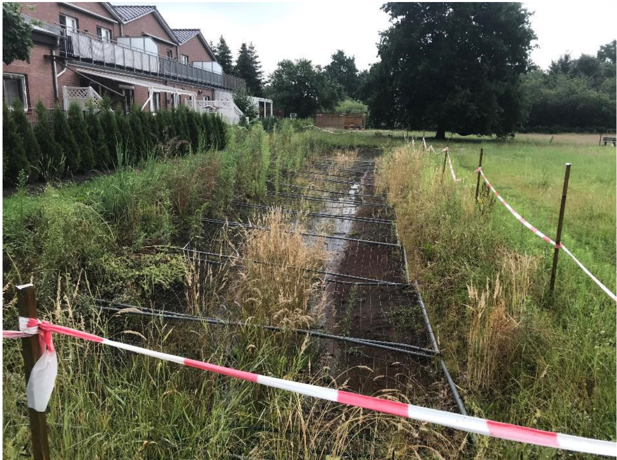
Abb. 3 noch nicht ganz fertig gestelltes Regenrückhaltebecken mit Pioniervegetation, Biotopnr. 5
