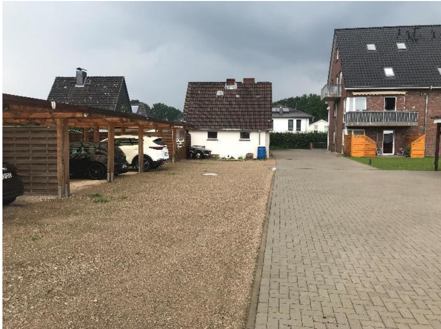
Abb. 5 Wohnbauung und Carport-Anlage an der nördlichen Einfahrt (SBe) Biotopnr. 1, versiegelte Verkehrsfläche (SVs, Biotopnr. 2)
